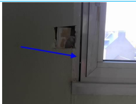
Matériaux : ZPSO-031 Prélèvement : P041 Description : Enduits à base de plâtre, lissés ou talochés Localisation : 1er étage - PALIER Résultat : Absence d'amiante
