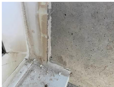
Matériaux : ZPSO-004 Prélèvement : P004; P014 Description : Sur joint d'étanchéité Localisation : 2ème étage_Aile droite - Bureau 210; 2ème étage_Aile droite - Bureau 206; 1er étage - Dégt 1 Résultat : Absence d'amiante
