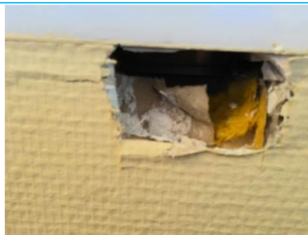
Matériaux : ZPSO-002 Prélèvement : P002 Description : Plot de colle fixant les cloisons au mur Localisation : 2ème étage_Aile droite - Bureau 210 Résultat : Absence d'amiante
