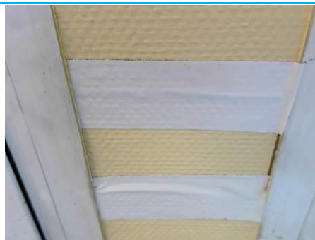
Matériaux : ZPSO-008 Prélèvement : P008 Description : Enduit de jointoiment des plaques de plâtre Localisation : 2ème étage_Aile droite - Bureau 210 Résultat : Absence d'amiante
