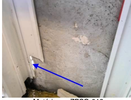
Matériaux : ZPSO-012 Prélèvement : P012 Description : JOINT DE CALFEUTREMENT ENTRE CADRE ALU ET MACONNERIE Localisation : 2ème étage_Aile droite - Bureau 206 Résultat : Absence d'amiante
