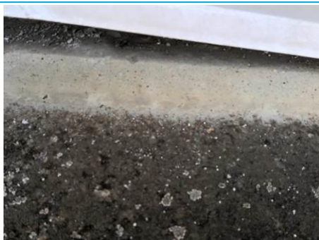
Matériaux : ZPSO-003 Prélèvement : P003; P013; P021 Description : Joint d'étanchéité entre menuiserie et structure (pièce d'appui) Localisation : 2ème étage_Aile droite - Bureau 210; 2ème étage_Aile droite - Bureau 206; 2ème étage_Aile Gauche - Bureau 214; 1er étage - Dégt 1 Résultat : Absence d'amiante
