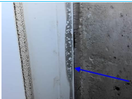
Matériaux : ZPSO-005 Prélèvement : P005; P015; P022; P029 Description : Joint d'étanchéité entre menuiserie alu et structure béton (extérieur) Localisation : 2ème étage_Aile droite - Bureau 210; 2ème étage_Aile droite - Bureau 206; 2ème étage_Aile Gauche - Bureau 214; 1er étage - Dégt 1 Résultat : Absence d'amiante
