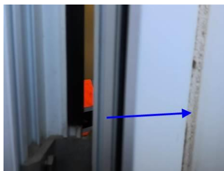
Matériaux : ZPSO-006 Prélèvement : P006; P016; P023; P030 Description : Joint d'étanchéité entre menuiserie alu et cadre alu posé sur maçonnerie Localisation : 1er étage - Dégt 1 Résultat : Absence d'amiante
