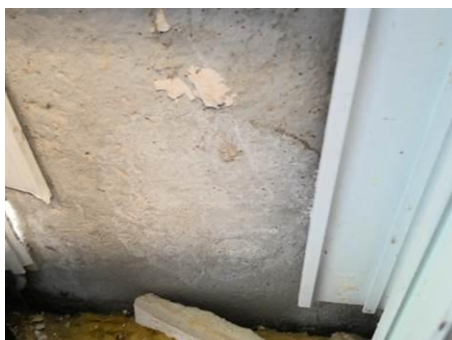
Matériaux : ZPSO-011 Prélèvement : P011 Description : Plot de colle fixant les cloisons au mur Localisation : 2ème étage_Aile droite - Bureau 206 Résultat : Absence d'amiante
