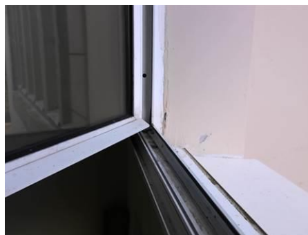
Matériaux : ZPSO-029 Prélèvement : P039 Description : Joint d'étanchéité entre menuiserie et structure Localisation : 1er étage - PALIER Résultat : Absence d'amiante
